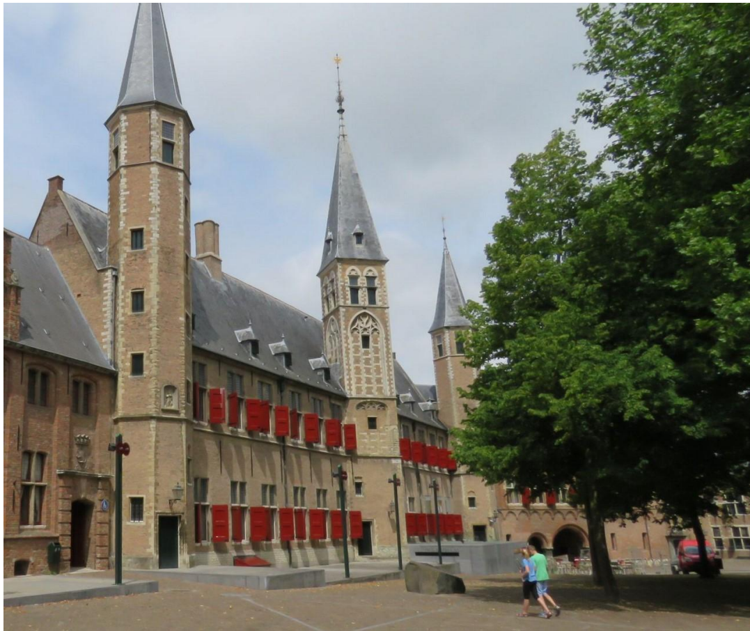
50 De situatie nu met links het totaal verbouwde poortje.
