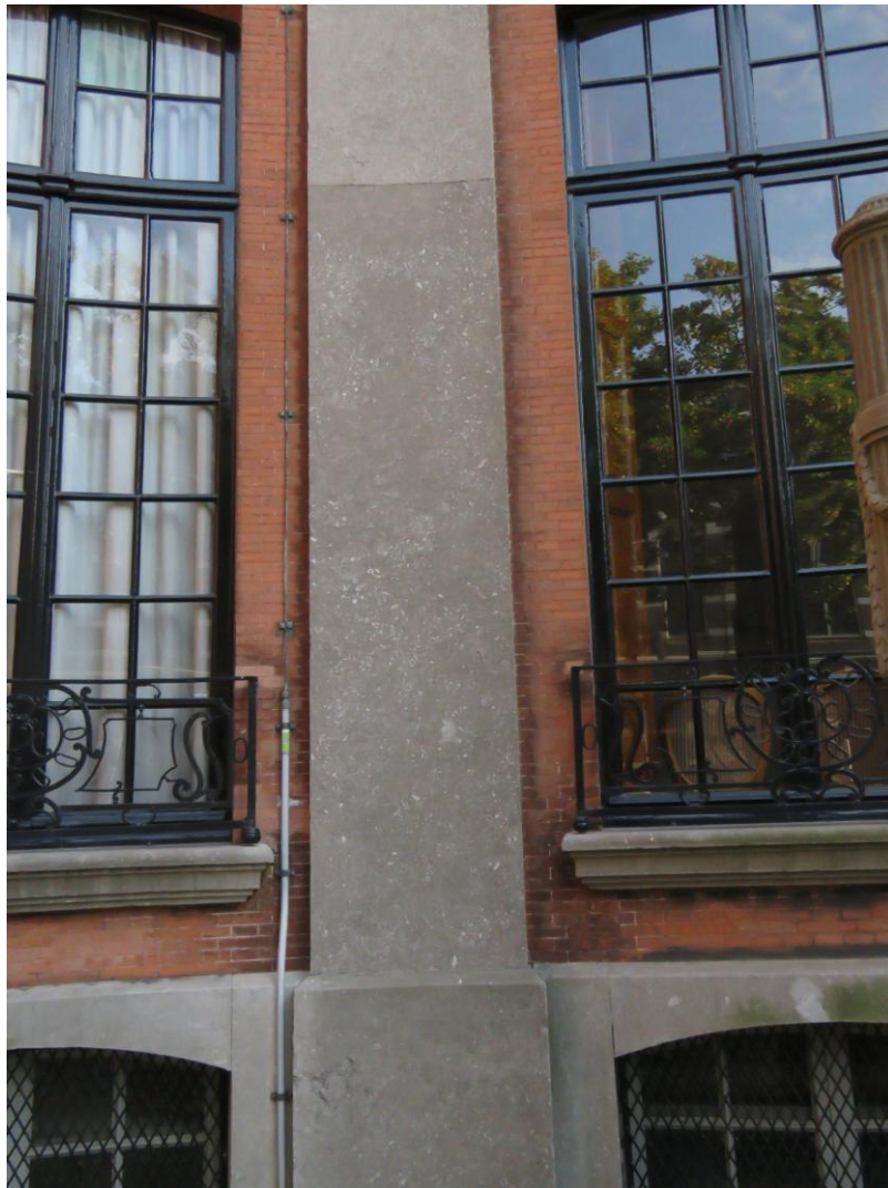
280 In de gevel zit tussen de vensters een plaat van ruim 2 meter hoog van Arduin. Volgens mij de rijkst gevulde plaat die we in Middelburg te zien krijgen, vol met fossielen.
