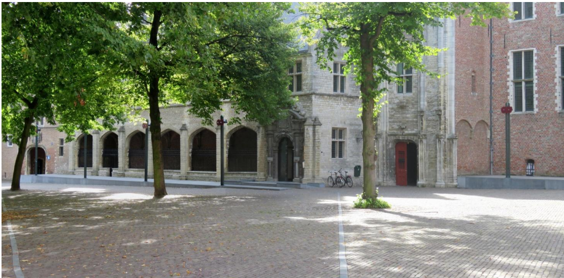
110 Dit gebouw wordt ook wel de " Leeuwenkooi " genoemd, mede vanwege het traliewerk in de boogvensters aan de buitenzijde.
