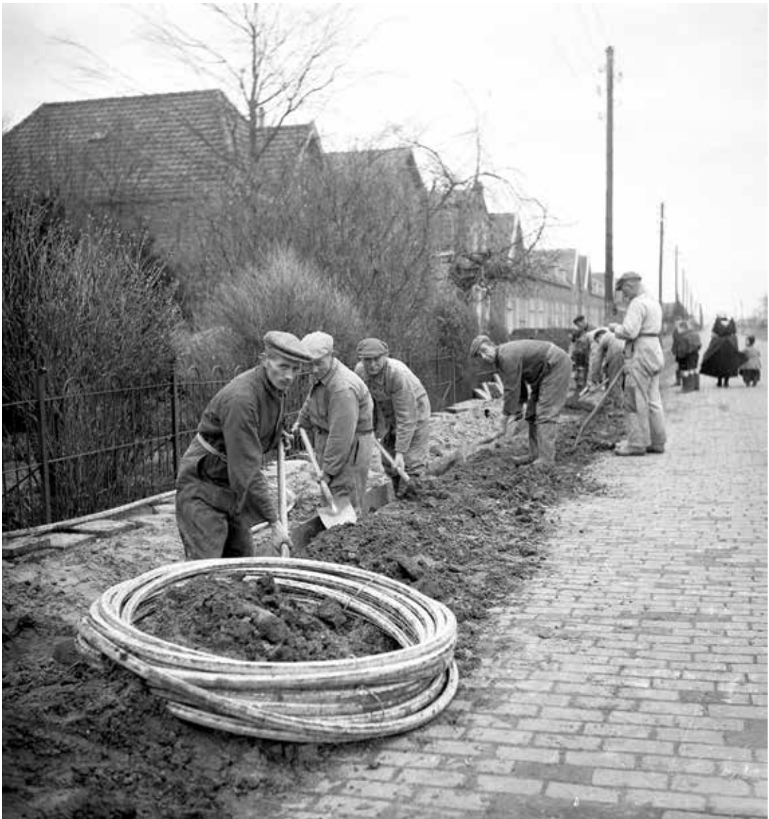
Het leggen van een laagspanningskabel voor de PZEM te Axel. ZB, Beeldbank, rec.nr. 65191.
