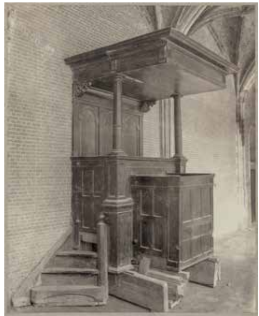
De orateurstoel opgesteld op balken in de kloostergang van de Middelburgse Abdij. Foto gemaakt door Cornelis Henning te Middelburg, vermoedelijk kort voor het transport naar Delft. Foto, Rijksdienst voor het Cultureel Erfgoed.
