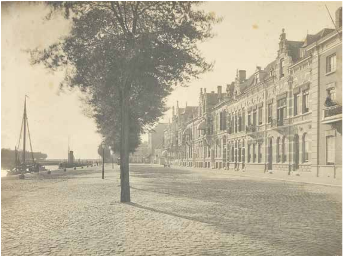
De Loskade te Middelburg. Foto C.W. Bauer, ca. 1900. ZA, ZG, ZI, aanwinst 1057.
