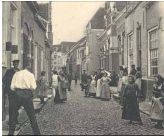
De Kromme Elleboog, gezien vanuit de Dalemsestraat in Tholen. Prentbriefkaart uit het begin van de 20e eeuw. Gemeentearchief Tholen.
